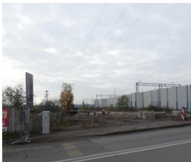
Zintegrowane węzły przesiadkowe w Mosinie, Pecnej, Drużynie - w budowie
