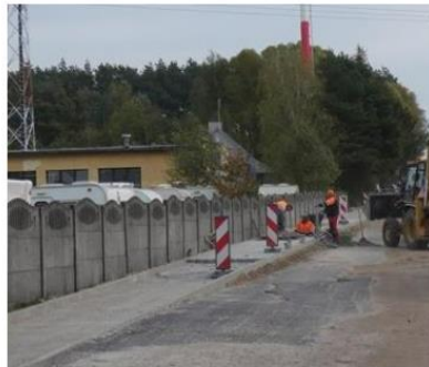
Czapury, ul. Spokojna - w budowie
