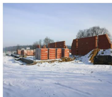
Budowa sali gimnastycznej przy SP w Rogalinie - mury
