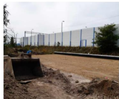
Zintegrowane węzły przesiadkowe w Mosinie, Pecnej, Drużynie - w budowie
