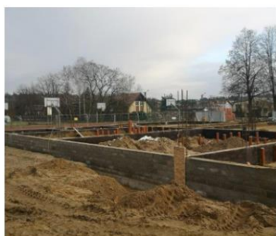
Budowa sali gimnastycznej przy SP w Rogalinie - fundamenty
